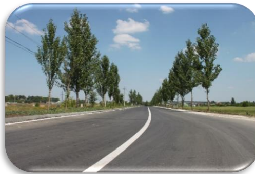
Conectarea Zonei Economice Libere „Bălți” la utilitățile municipale
