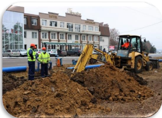
Îmbunătățirea serviciilor de alimentare cu apă în orașul Edineț
